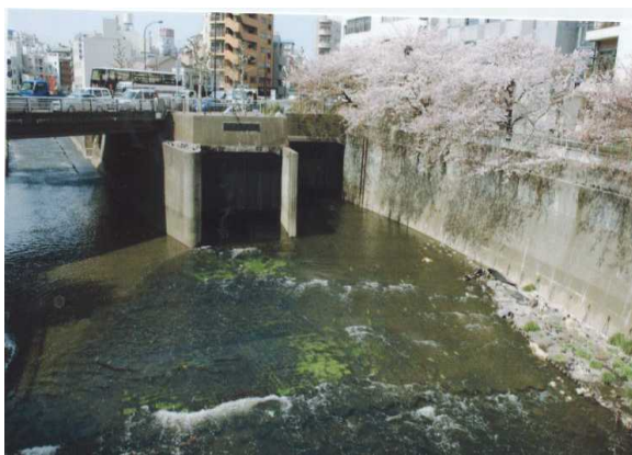
高田橋下流の分水路合流点
