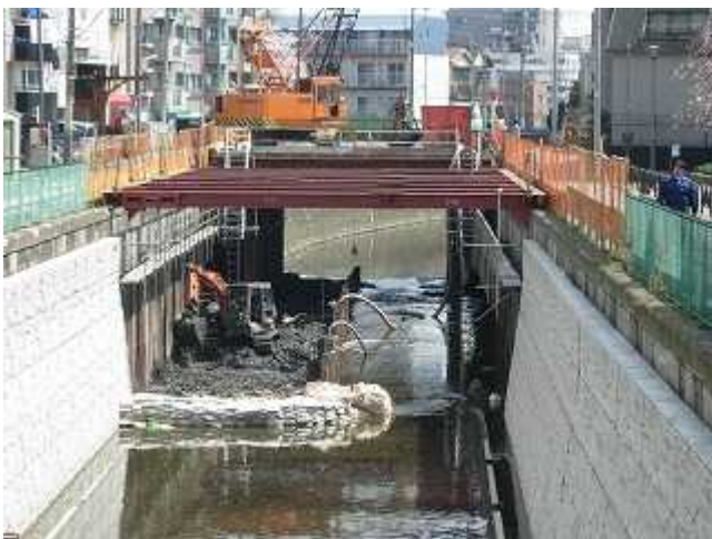
左の写真は現在施工中の 仲之橋～八幡橋間のその7工事 写真上部が下流方向
