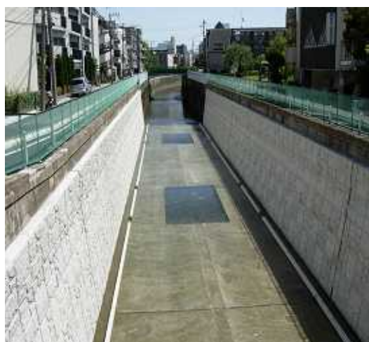
八幡橋下流側の鯉の遡上していた開口部
