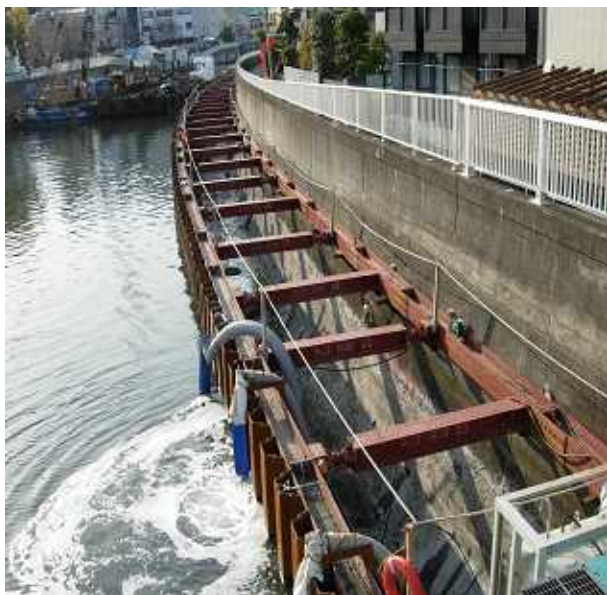
昨年度施工の夫婦橋～天神橋間の左岸
